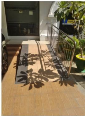
Jalur Masuk Gedung Bagi Difabel
